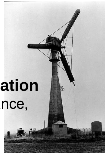
Danish AC-producing 200kW turbine at Gedser 1959 (J. Juul)
